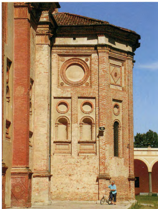
Sanctuaire de la Misericordia di Castelleone (Cremona, Lombardie) après restauration timide sous la direction de Marco Ermentini. (1999-2005) © Archivio SAA
